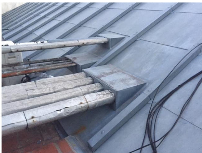
Capuchón de zinc existente
